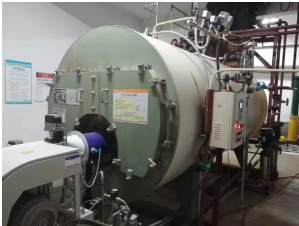
图 4-9 燃气锅炉
