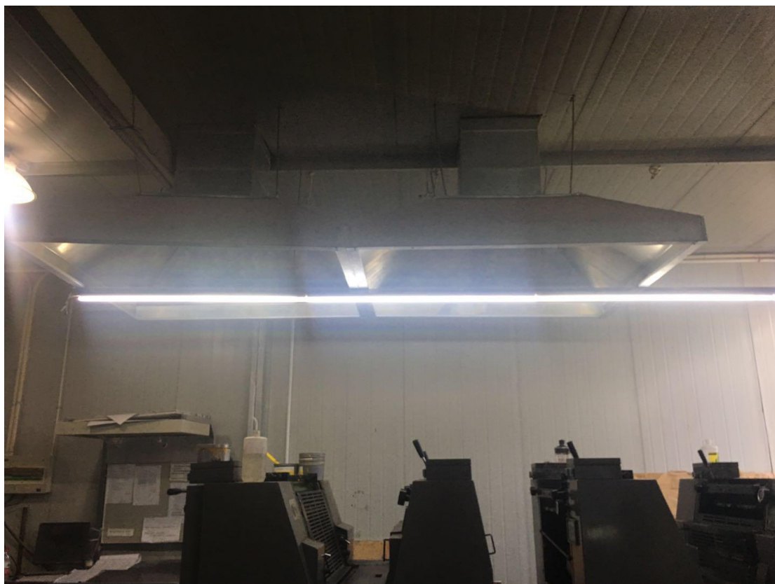
项目现场废气收集系统
