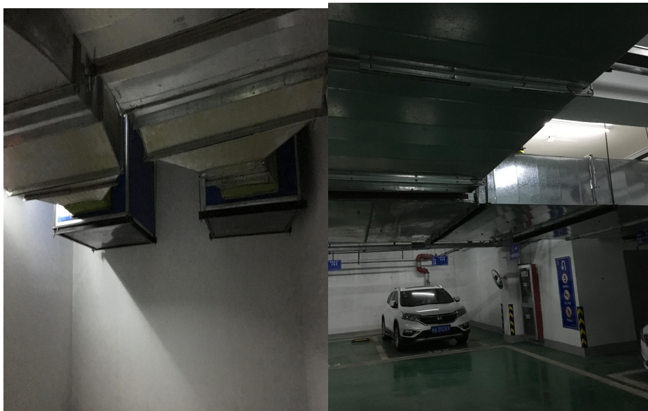
地下车库通风管道和排风机
