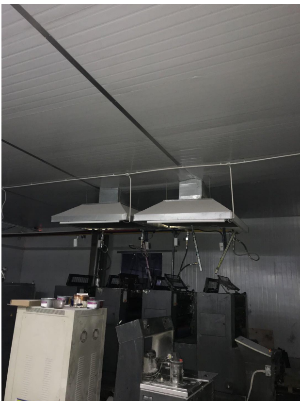
项目现场废气收集系统
